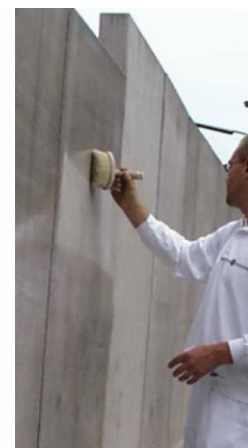
Po drugem nanosu je potrebno PAG s čopičem vtreti v površino
